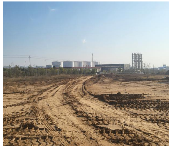
项目厂址东北侧
