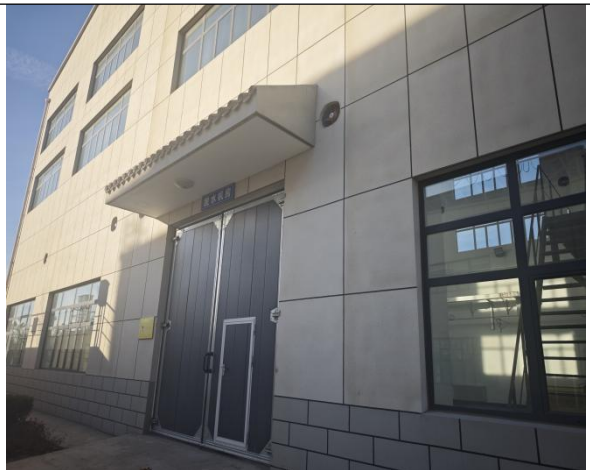
现有工程脱水机房
