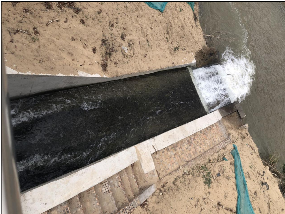
图 5.1-2 入河排污口八字式明渠
