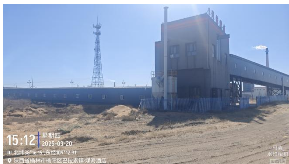
现有输煤廊道
