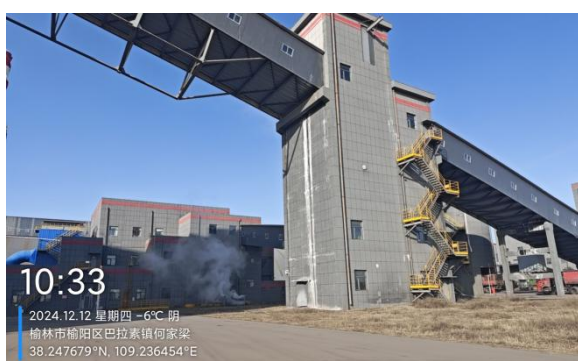
现有矸石仓(栈桥后)
