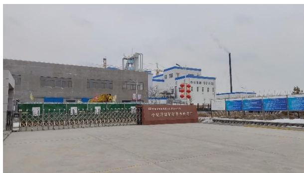
现有水处理站
