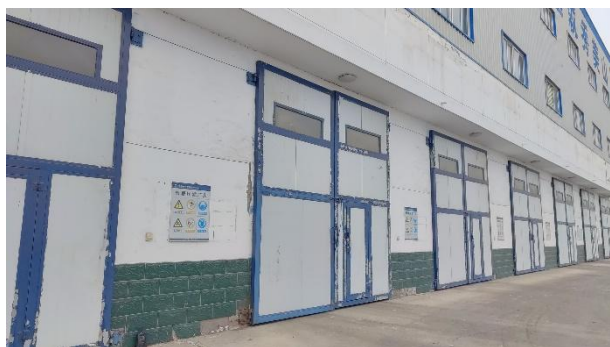
污泥压滤车间
