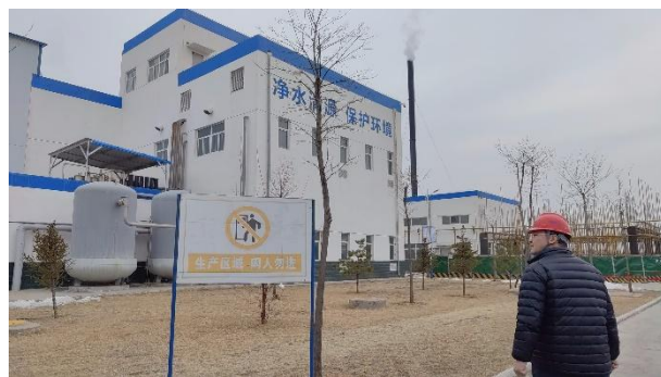
蒸发结晶车间及锅炉房
