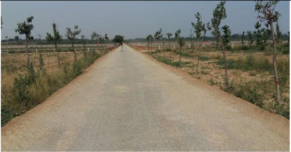
图 2-8 泥结石路面示意图
