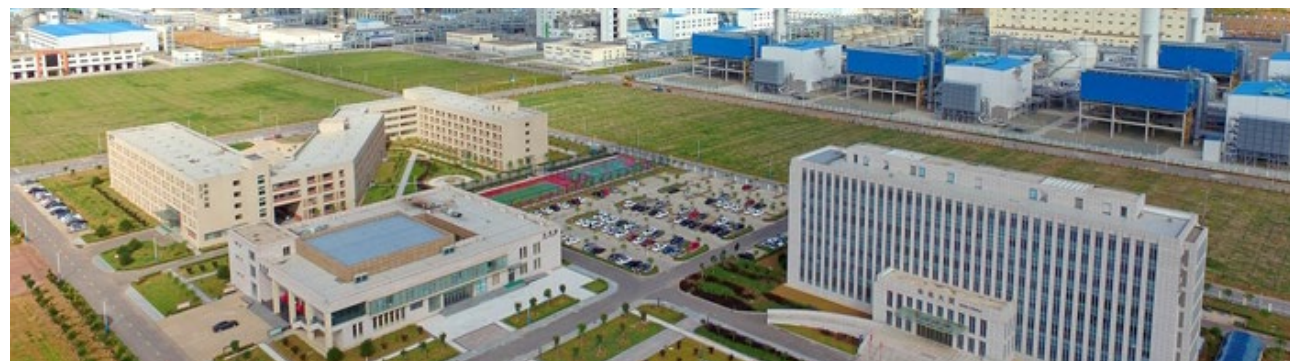
陕西未来能源煤间接液化一期后续项目
