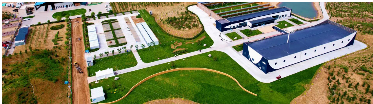
榆阳区军旅园至女子民兵治沙连景区道路提升改造工程
