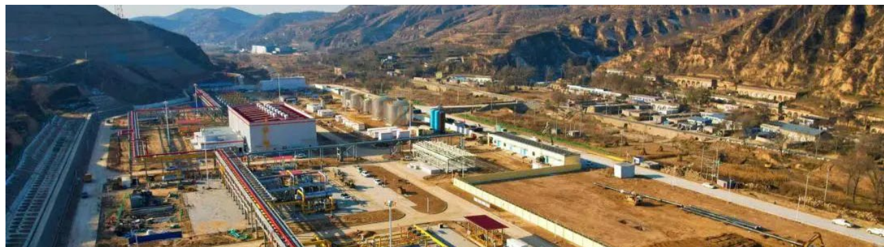
榆阳至靖边输气管道工程建设用地项目
