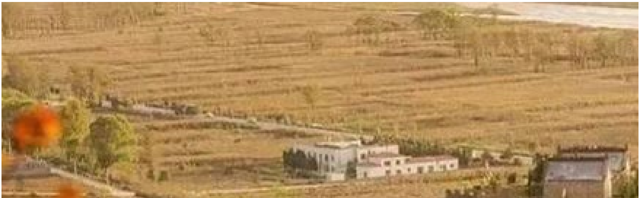
西部土地沙化生态治理区榆林市沙化土地治理工程
