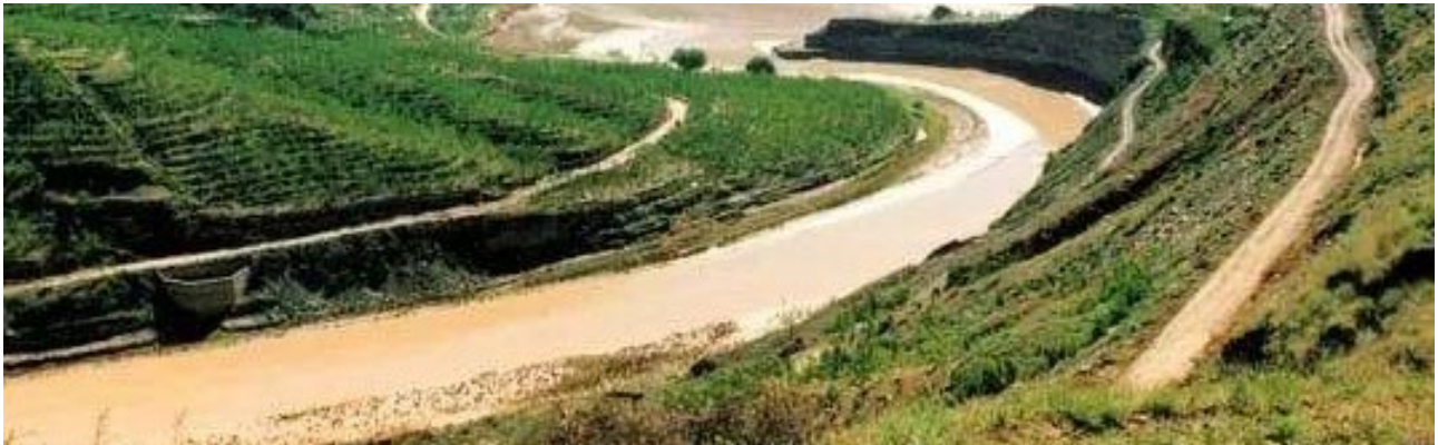
北部水土流失生态修复区水土流失治理工程
